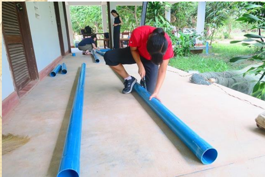
現地で材料を加工
